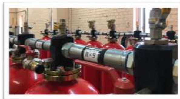
Установка пожаротушения тонкораспыленной водой с добавками модульного типа (МУПТВ)
