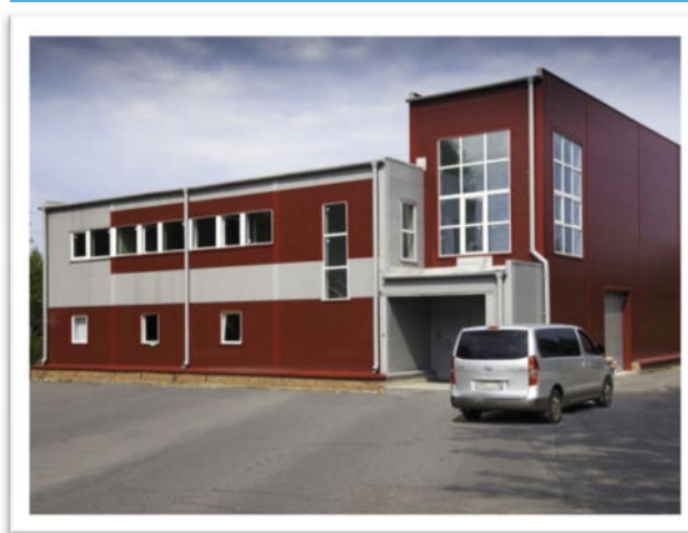
Административно-складское здание, Рыбинск
