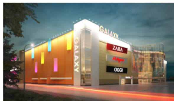
Торговый центр «Галактика», г. Барнаул
