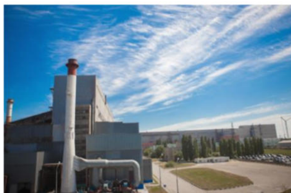
ОАО «Стойленский ГОК», проектные и строительно-монтажные работы
