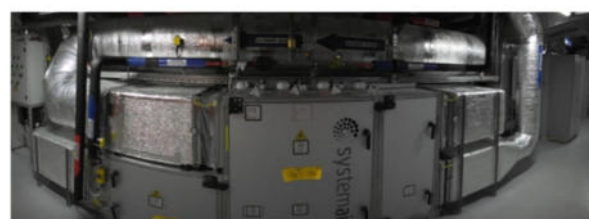
Реконструкция системы отопления Собора Воскресения Христова (Спас на крови)
